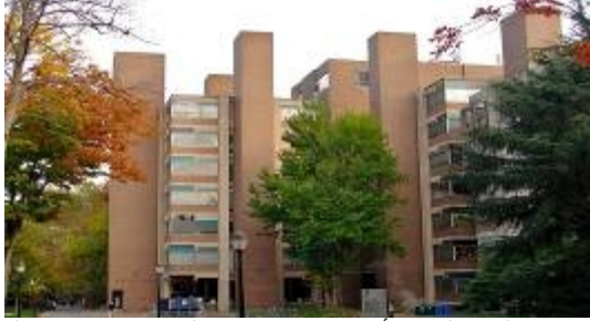
شكل (٢٣) لقطة لمبنى أبحاث ريتشاردز الطبي بجامعة بنسلفانيا، ١٩٥٧ من تصميم لويس كان - بنسلفانيا ويظهر الاهتمام بالمعالجات التشكيلية لمفردات العمل المعماري باللجوء غالباً للتعبير الرأسي مع أكبر قدر من الحوائط المصمتة وبالتالي بين الواجهات المصمتة الخشنة لكثلة الخدمات والزجاجية المساء للكتل المخدومة
