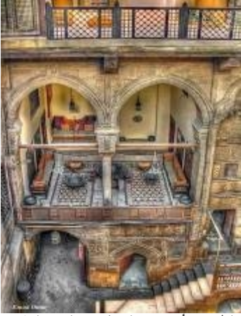
شكل (١٤) بالطابق الأرضي سلم يفضى إلى "المقعد" وهو شرفة مسقوفة تتفتح على صحن الدار، ويكون موجهًا للجهة الشمالية ليتلقى الهواء البارد في الصيف
